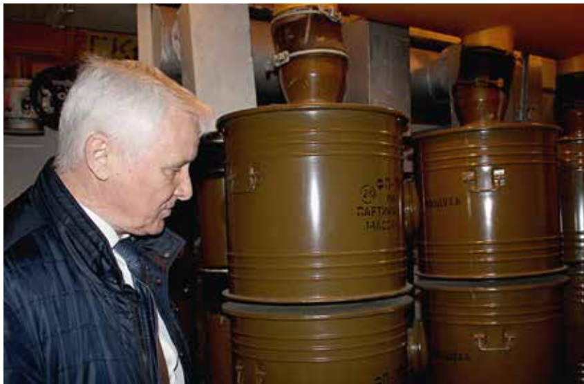
Воздух поступает в защитные сооружения через мощные фильтровентиляционные установки, которые не пропускают радиоактивную пыль
