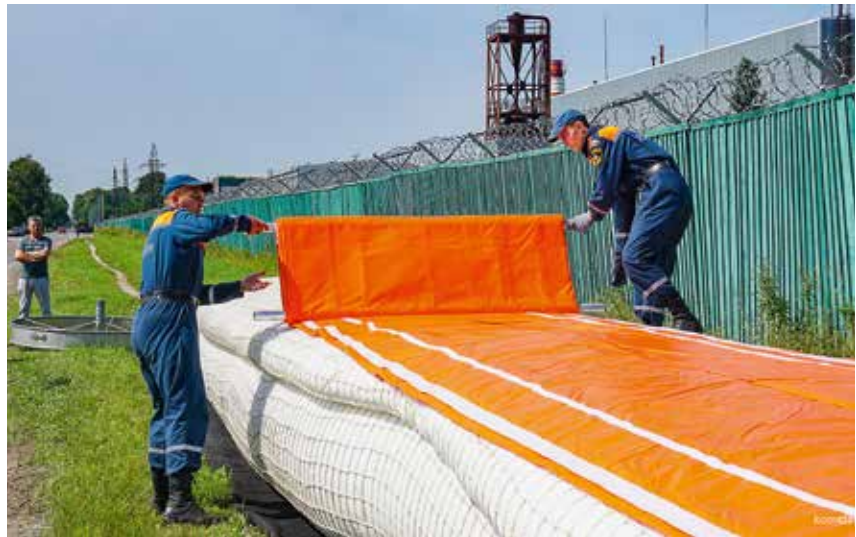
Установка водоналивных противопаводковых дамб, Хабаровский край
