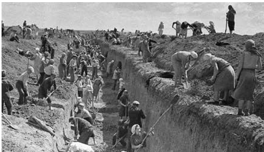
Строительство оборонительных сооружений на подступах к Москве, сентябрь 1941 г.
