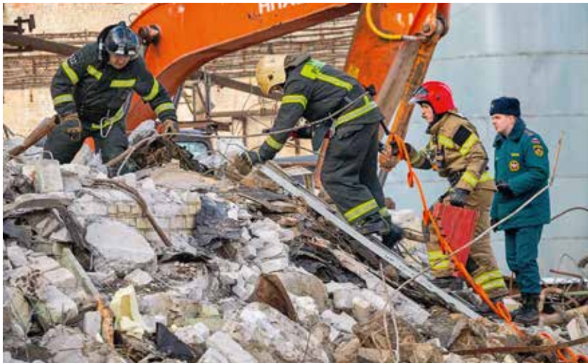
Проведение поисково-спасательных работ в обрушенных зданиях
