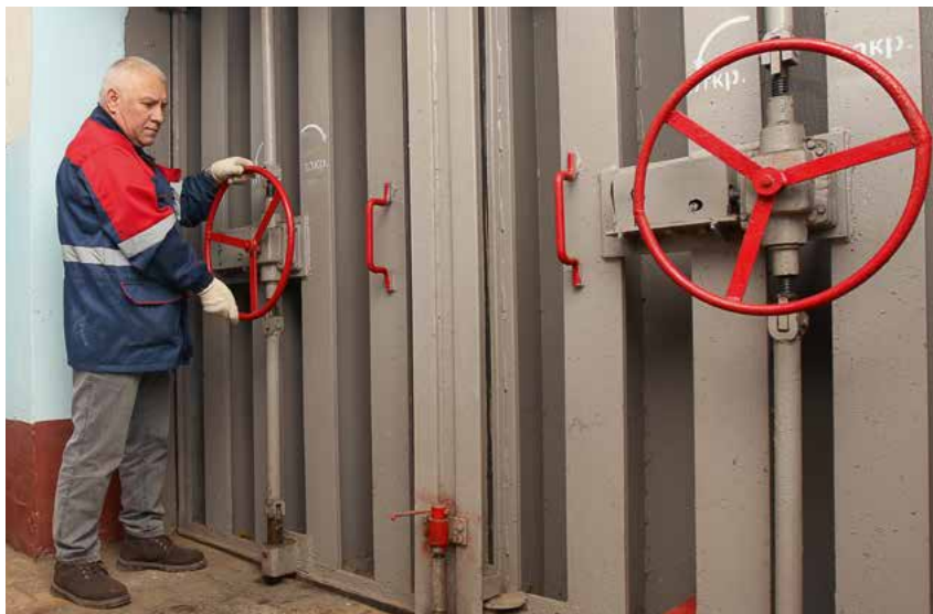
Защитное сооружение ГО – для укрытия населения в ЧС военного и мирного времени
