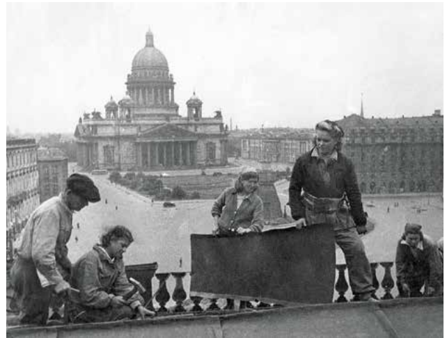
Девушки – бойцы МПВО ремонтируют крышу здания
