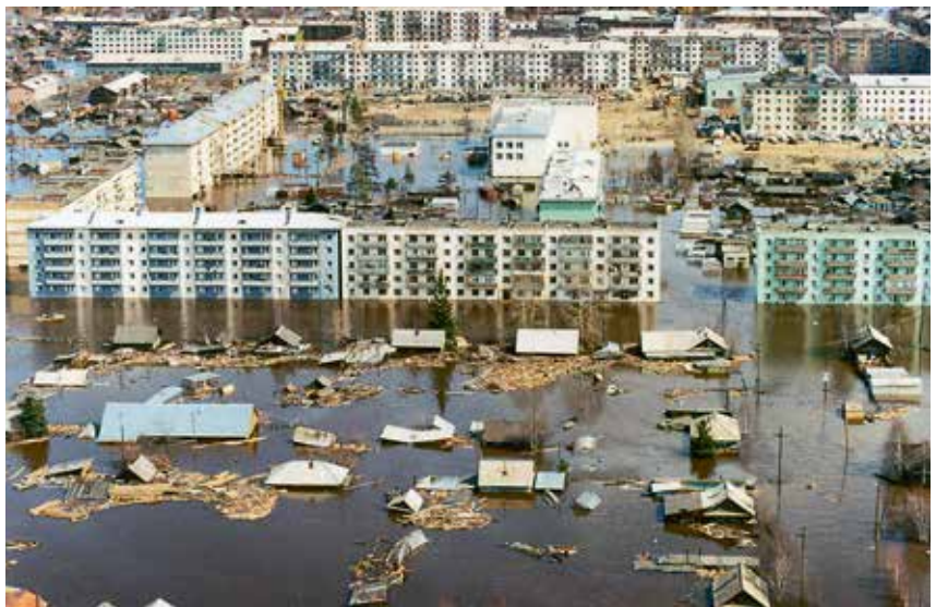
В мае 2001 г. город Ленск был фактически полностью разрушен катастрофическим наводнением
