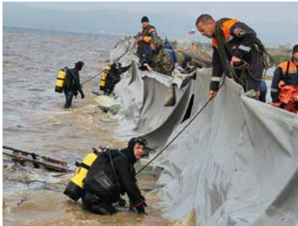
Водолазы МЧС проводят работы по укреплению Мылкинской дамбы в Хабаровском крае, 2013 г.
