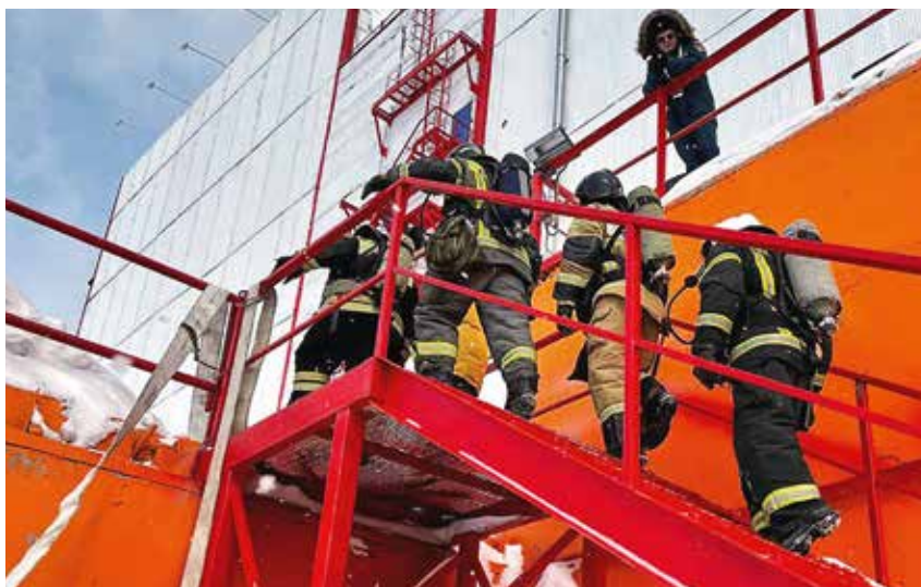
Пожар и взрыв с обрушением части здания ТЭЦ, г. Анадырь, Чукотка
