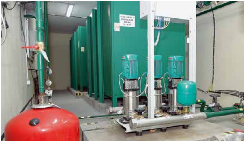
Система водоснабжения убежища Белоярской АЭС
