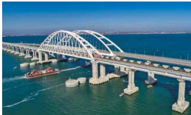
Экспертами ВНИИПО разработаны требования к огнезащитным конструкциям и системам противопожарной защиты Керченского моста
